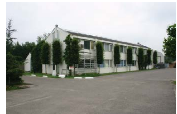
Foto bestaande situatie
