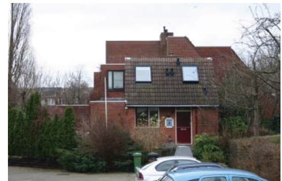
Foto bestaande situatie
